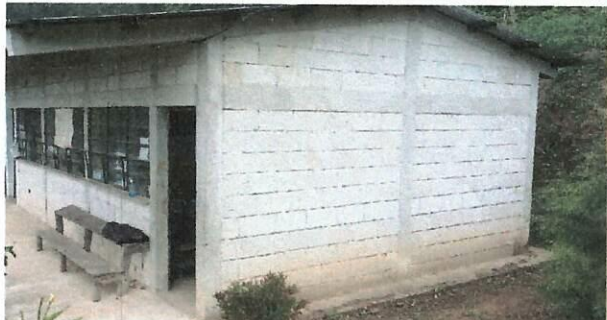
Foto 6: Se Mejorará y se sustituirá el piso a granito del salón de clases.
