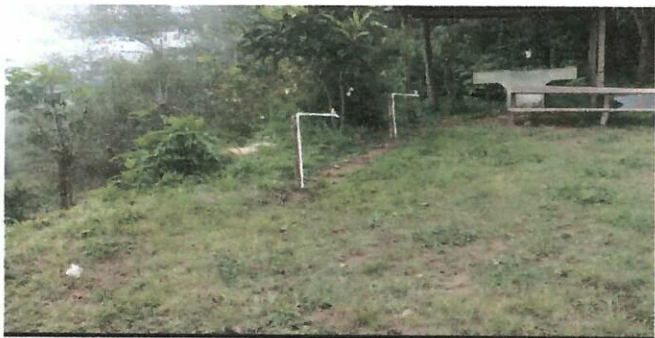
Foto 3: Se Mejorará e instalará la estructura de sistema porticó (tubos y costaneras metálicos), 3 hiladas de block + cimentación + solera para el perímetro del mismo.
