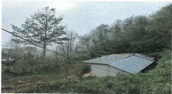
Foto 5: Se instalará Capote para el techo de la estructura sistema pórtico.
