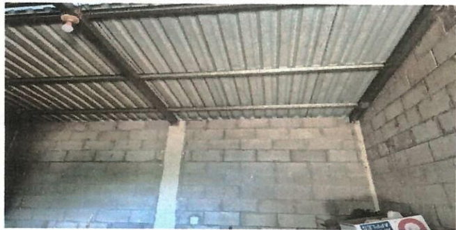
Foto1: Se Mejorará la pintura de la pared de la cocina del Centro Educativo
